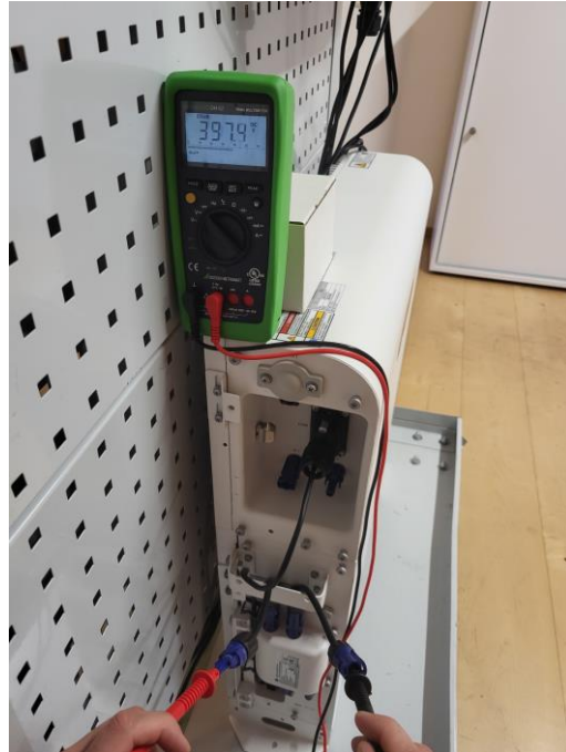
DC-Ausgangsspannung am Modul mit Anschlusskabeln messen
