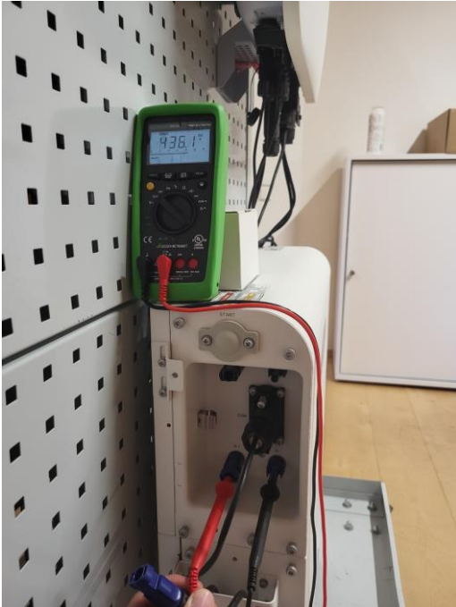
DC-Ausgangsspannung am BMS messen
